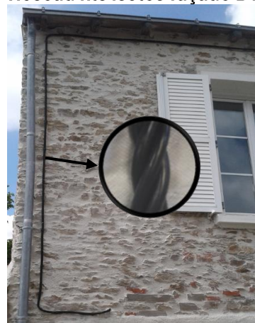
Réseau fils isolés façade BT
